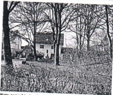
Platz gemacht: An der Saarlandstraße, direkt am Fuße des Schlittenbergs, haben Bauhof-Mitarbeiter praktisch über Nacht Bäume gefällt, darunter eine alte Eiche.
