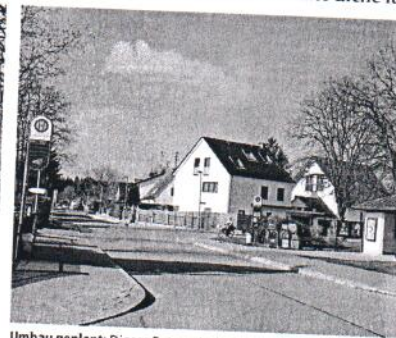
Umbau geplant: Dieses Foto zeigt die neu sanierte Gartenstraße. Rechts die Haltestelle, die in die Querstraße, die Saarlandstraße, verlegt wird.
